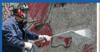
LIMPIEZA DE GRAFFITIS Mantenimiento de fachadas
