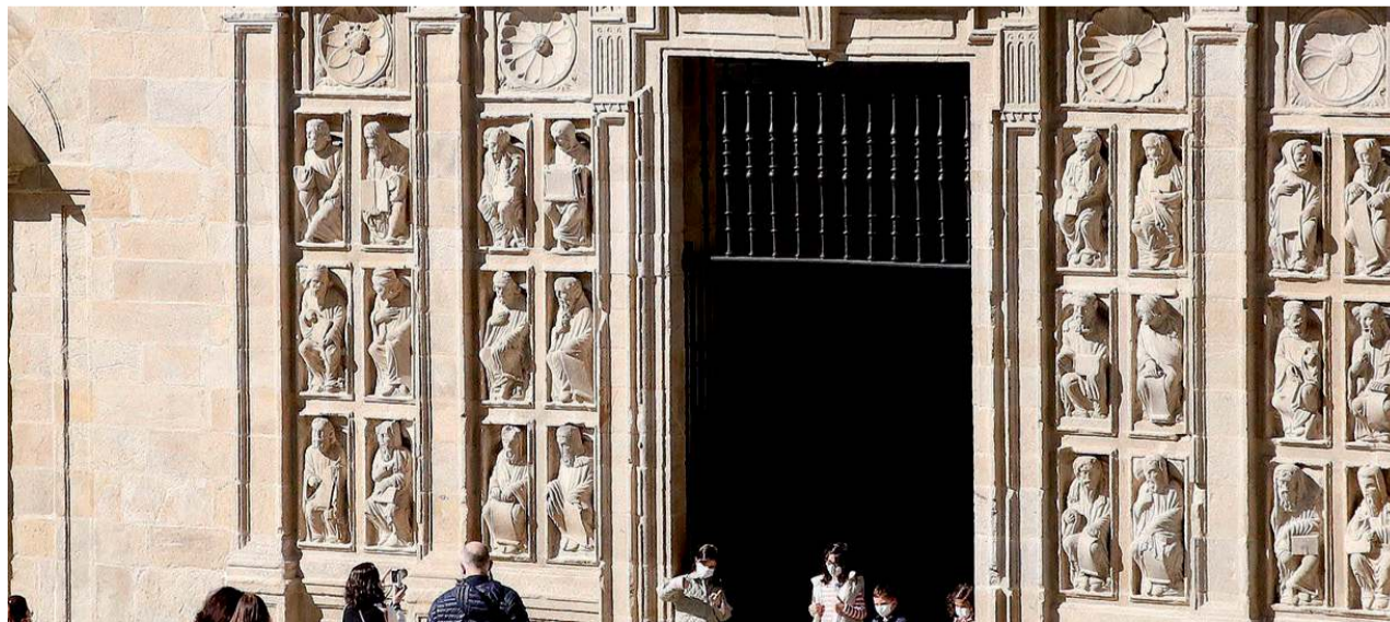
El actual acceso exterior a la Puerta Santa fue añadido en el siglo XVII. Peña de Toro y Domingo de Andrade completaron el proyecto de Jácome Fernández y González de Araújo. Foto: ECG
