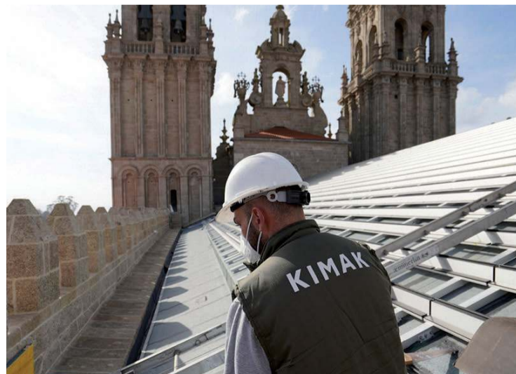
CORTIZO y Kimak colaboraron estrechamente en el desarrollo de la nueva cubierta. Foto: Kimak
